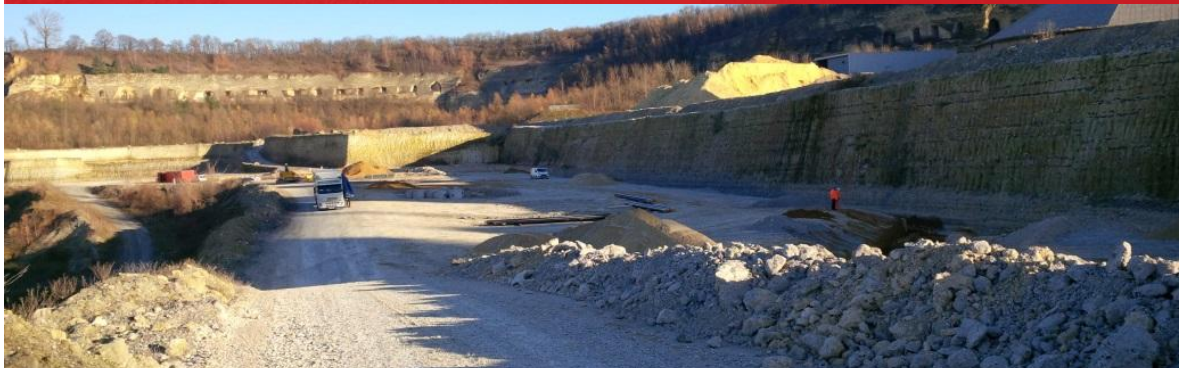
Eerste deel overgangszone bouwrijp gemaakt
