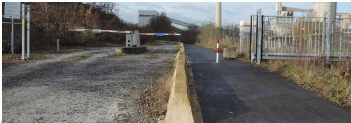
(tijdelijke) Zuidelijke toegangsweg
